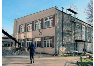
Termomodernizacja SP nr 5
