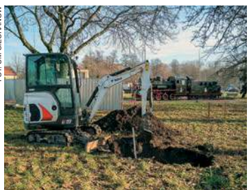
Rekonstrukcja budynku Kolei Nadwiślańskiej
