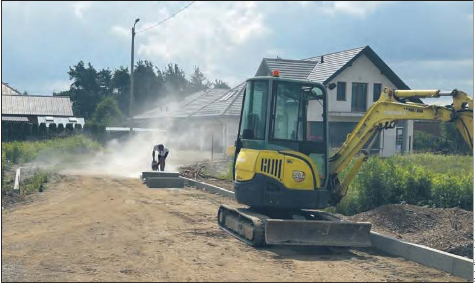
Trwają prace na ulicy Leśnej w Sobolewie
