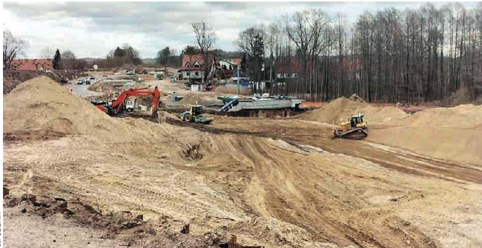
Obecnie trwa budowa odcinka „szesnastki” od Borek Wielkich do Mrągowa, który ma być gotowy w listopadzie tego roku
