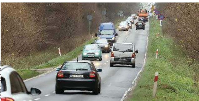
Budowa obwodnicy Olsztyna i Dywit zakłada też przebudowę drogi 51 przez Las Miejski
