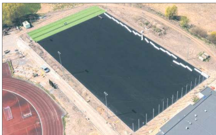
Teren HOSiR przechodzi gruntowną przebudowę.
