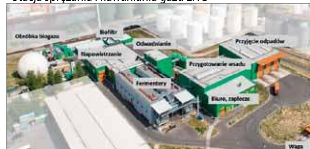
Przykładowa Instalacja fermentacji w BSR Berlin
