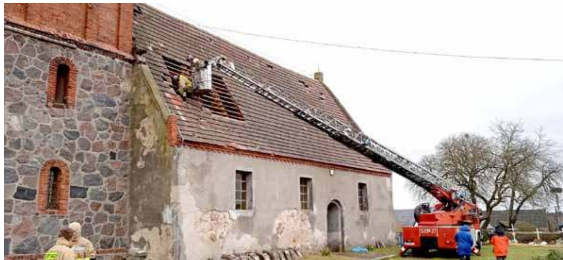
W minioną środę strażacy zostali zadysponowani do zabezpieczenia dachu kościoła w miejscowości Odargowo. OSP. Dobrzany
