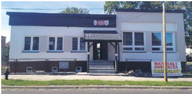
Budynek biblioteki w Tyszowcach jest w trakcie termomodernizacji.
