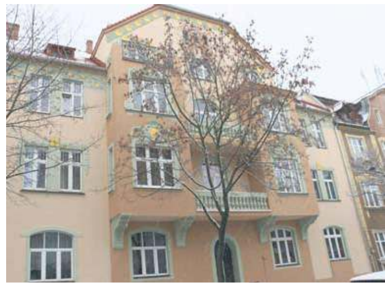
Kamienica przy Wyspiańskiego 9 – jedna z wyremontowanych przy udziale miejskiej dotacji w 2018 roku
