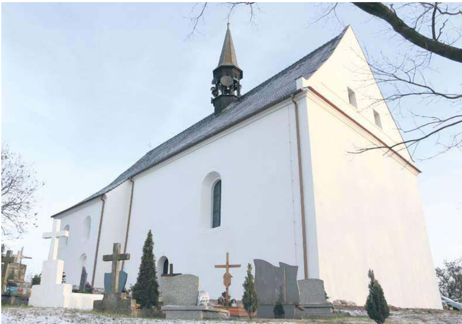
Wyremontowany kościół z zewnątrz znów wygląda imponująco
