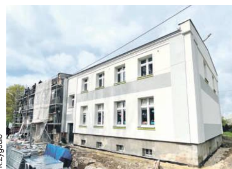
Remont i docieplenie elewacji budynku poszkolnego w Sobocisku.
