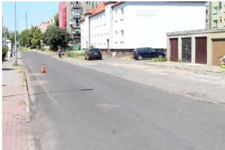
Już za kilka dni remont na ul. Czeskiej ma zostać zakończony.
