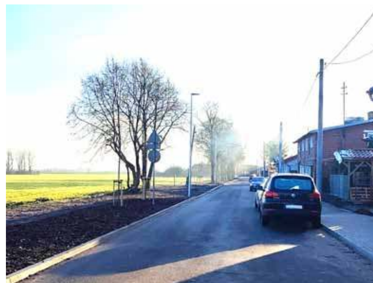
Kierowcy mają tam już do dyspozycji nową, dwupasmową jezdnię, a piesi – chodniki z kostki betonowej
