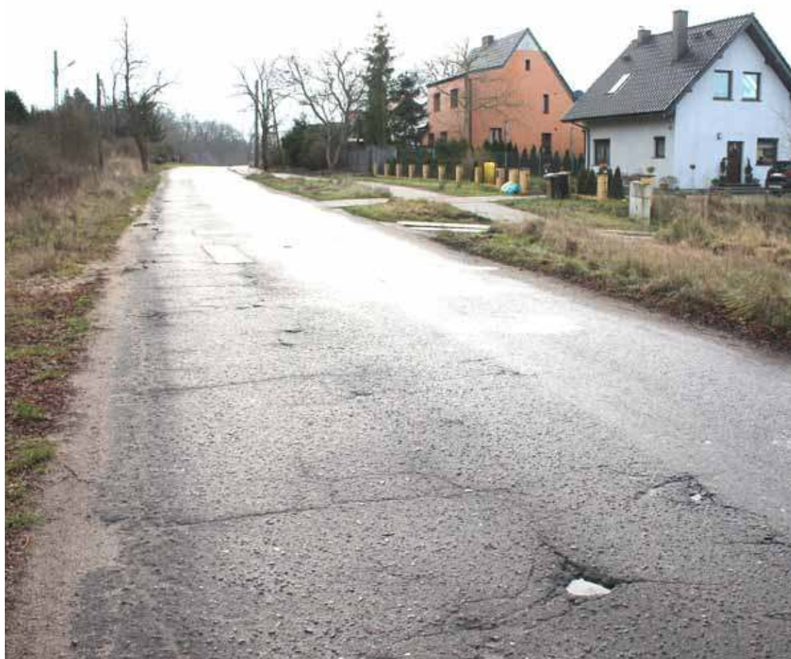
Remont nawierzchni i budowa chodników na części ulicy Morskiej mają zakończyć się wiosną 2024 roku
