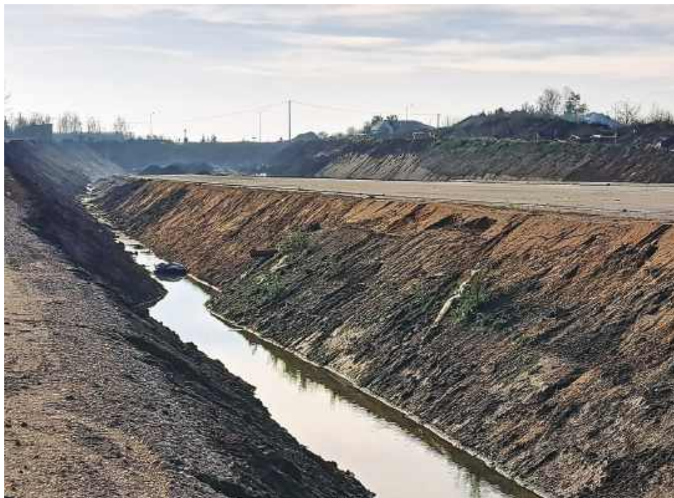
Fragment budowanej obwodnicy w Kleszewie
