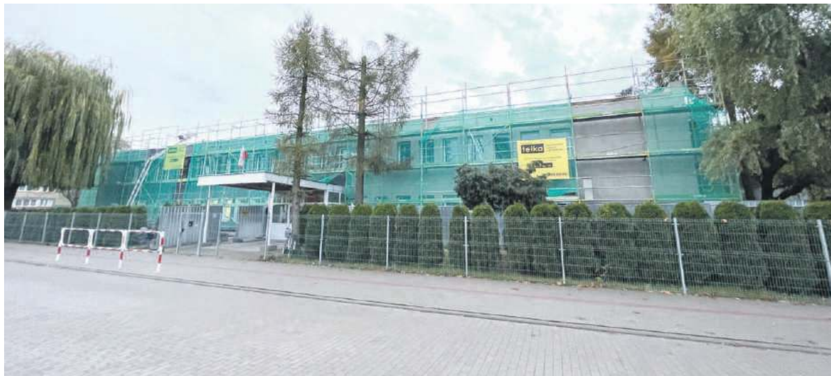
W Przedszkolu Publicznym nr 2 trwa remont
