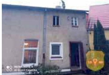
26 stycznia strażacy zostali zadysponowani do pożaru sadzy w przewodzie kominowym. Foto. OSP. Insko
