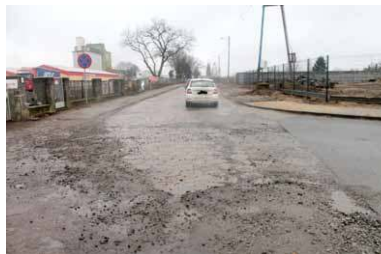
Wjazd na ul. Podmiejską od skrzyżowania z ul. Podleśną. Nawierzchnię stanowi tutaj bruk
