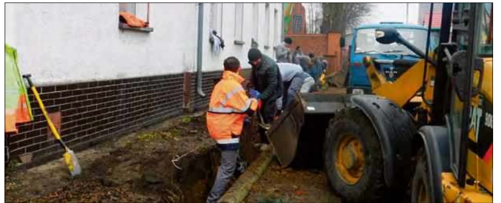
Podczas prac został m.in. rozebrany płot przed plebanią.
