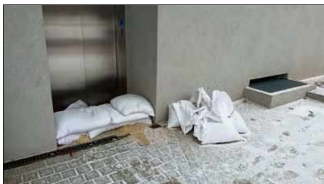
Worki z piaskiem wciąż zabezpieczają windę przed podtopieniami.
