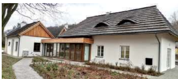
Zmodernizowaną „Wikarówkę” przy ul. Nadzecznej otwarto 18 grudnia. Z obiektu będą korzystać głównie osoby starsze i niepełnosprawne
