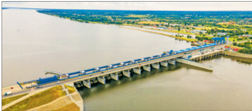
Koncepcja kaskadyzacji Wisły zakładała budowę ośmiu zapór. Powstała tylko jedna: we Włocławku
