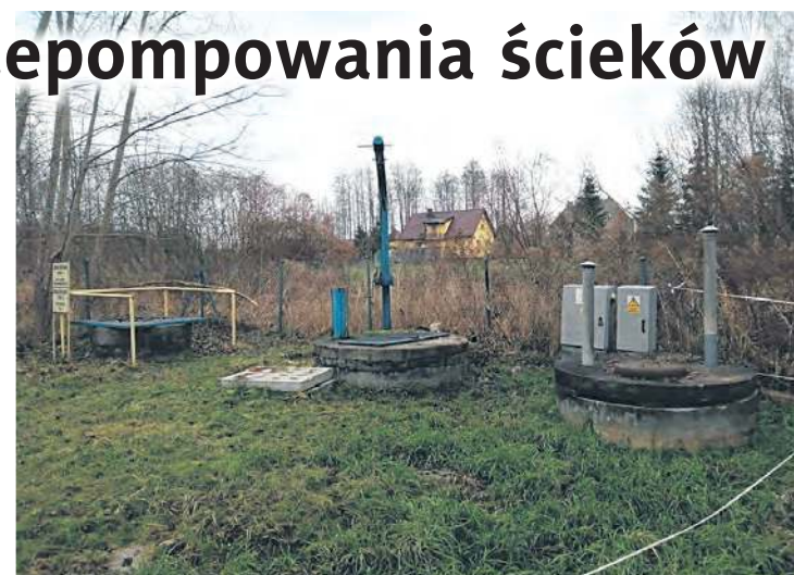
Obecna przepompownia ścieków w Drożdzienicy zostanie zlikwidowana.
