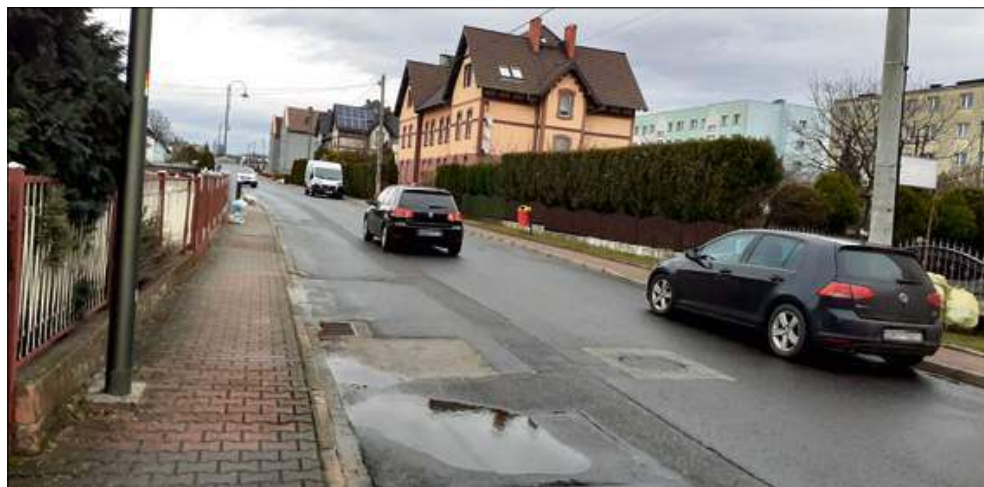
Ulica Powstańców doczeka się remontu i przebudowy.
