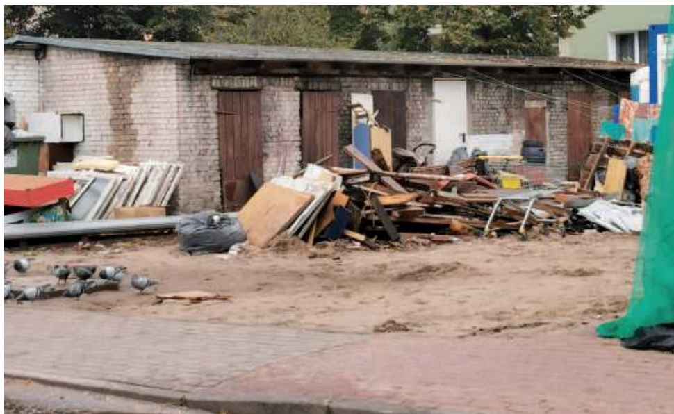
Komórki i podwórko przy ul. Nałęcz 35, gdzie obecnie prowadzony jest remont
