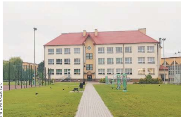
Przy Zespole Szkolno-Przedszkolnym nr 2 na osiedlu Tysiąclecia powstaną m.in. bieżnia do skoku w dal i rzutnia do pchnięcia kulą
