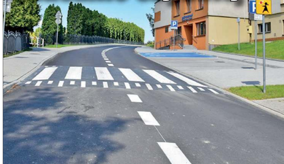
Przebudowa ul. Szkolnej miała potrwać do października. Zadanie udało się zrealizować znacznie wcześniej, bo jeszcze w lipcu.
