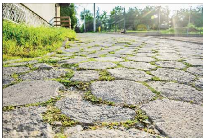
Ostatecznie 120 tys. zł przeznaczono na dokończenie remontu ul. Daszyńskiego na około 100-metrowym odcinku
