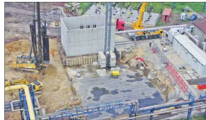
Najbardziej widoczne, zaawansowane prace przy budowie bloku energetycznego trwają w miejscu usytuowania budynku elektrycznego z nastawnią blokową
