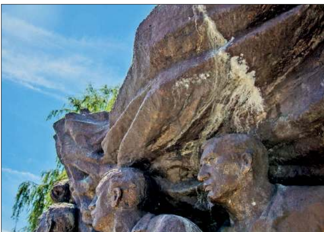
Monument zostanie m.in. oczyszczony i pokryty żywicą z proszkiem miedzanym
