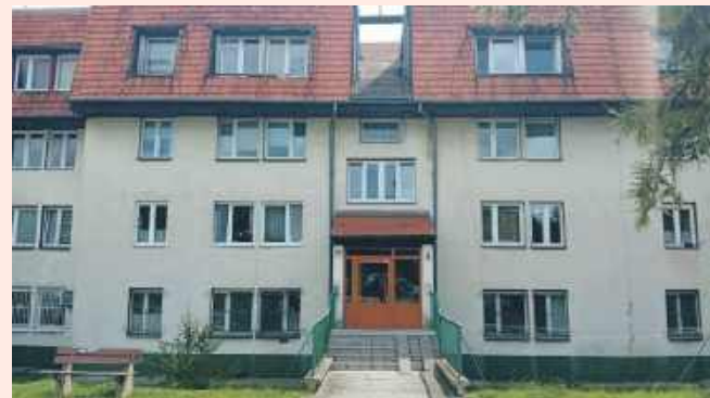
Uszkodzona deska zwisała nad tym wejściem
