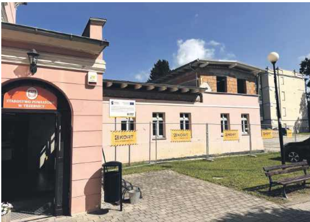
Remont oficyny ma kosztować kilka milionów
