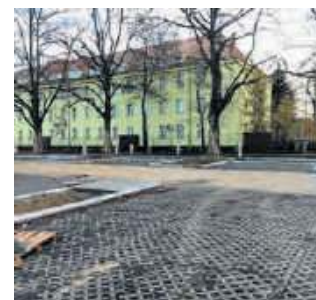
Trwają prace przy pętli w Podjuchach
