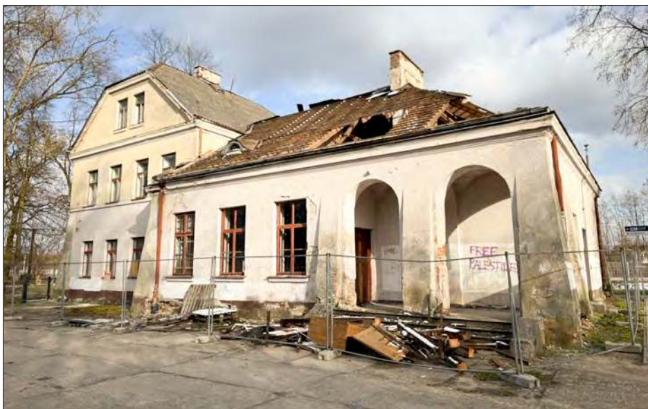
W piątek przy dworcu pojawiła się ekipa z zadaniem całkowitej rozbiórki. Rozpoczęto od usunięcia eternitu i więźby dachowej
