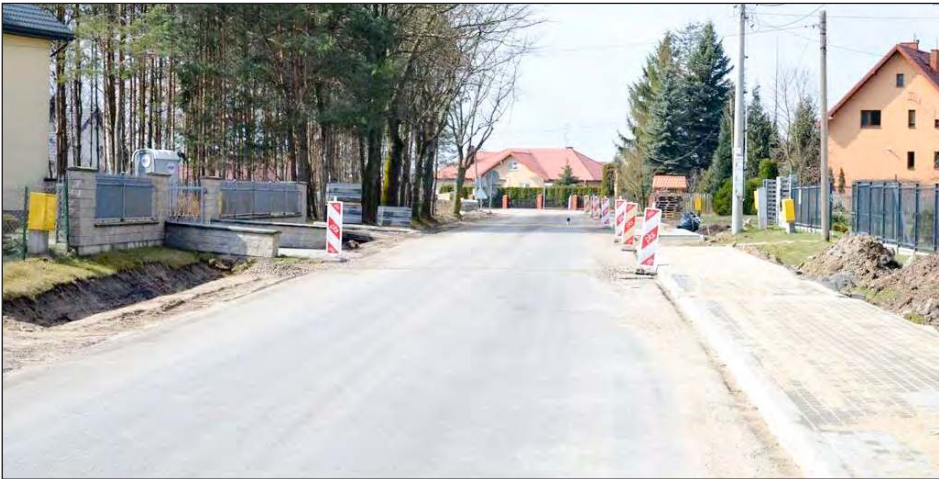
➡ Droga zyska nową nawierzchnię o szerokości 6 metrów
