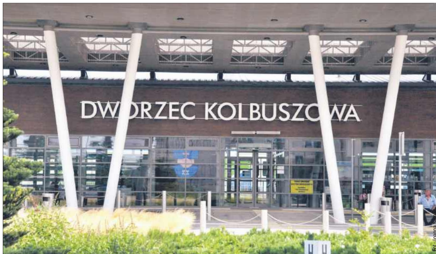
Na budowę kolbuszowskiego dworca wydano kilka milionów złotych. Obiekt świetnie się prezentuje z zewnątrz. W niedzielę tylko w ten sposób można go oglądać. Drzwi do obiektu są zamknięte.
