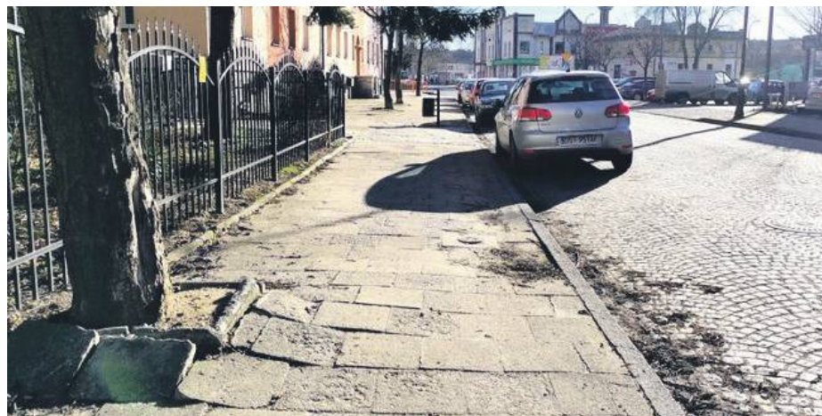
Za remont chodnika przy ul. Mickiewicza w Strzelinie będzie odpowiadała firma Globistic z Pęcza
