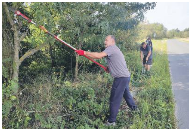
Jedną z robót było odcinanie gałęzi wychodzących nad drogę dojazdową
