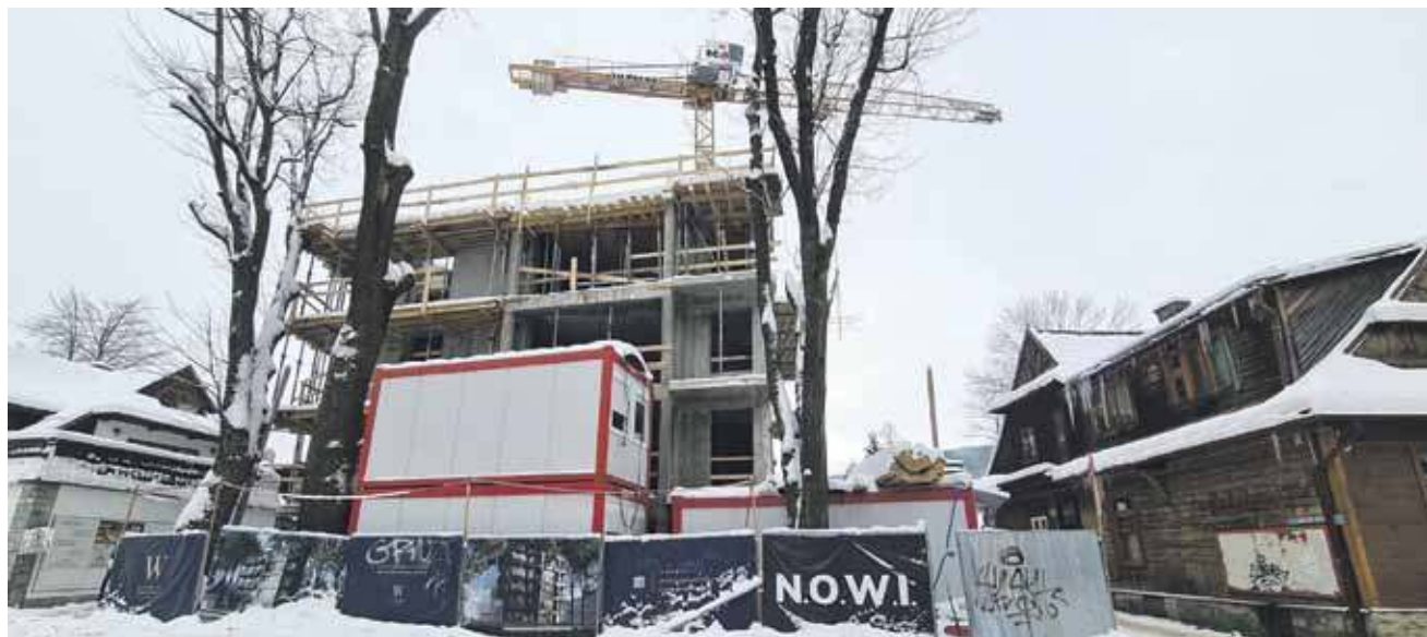
Deweloperska inwestycja przy ul. Witkiewicza w Zakopanem.
