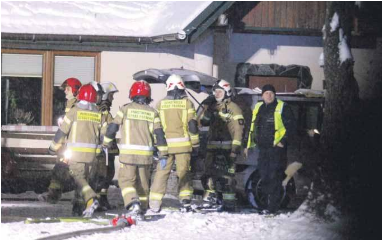
Wybuch poważnie uszkodził konstrukcję garażu.
