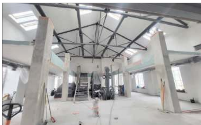
■ Wewnątrz postępują prace wykończeniowe
