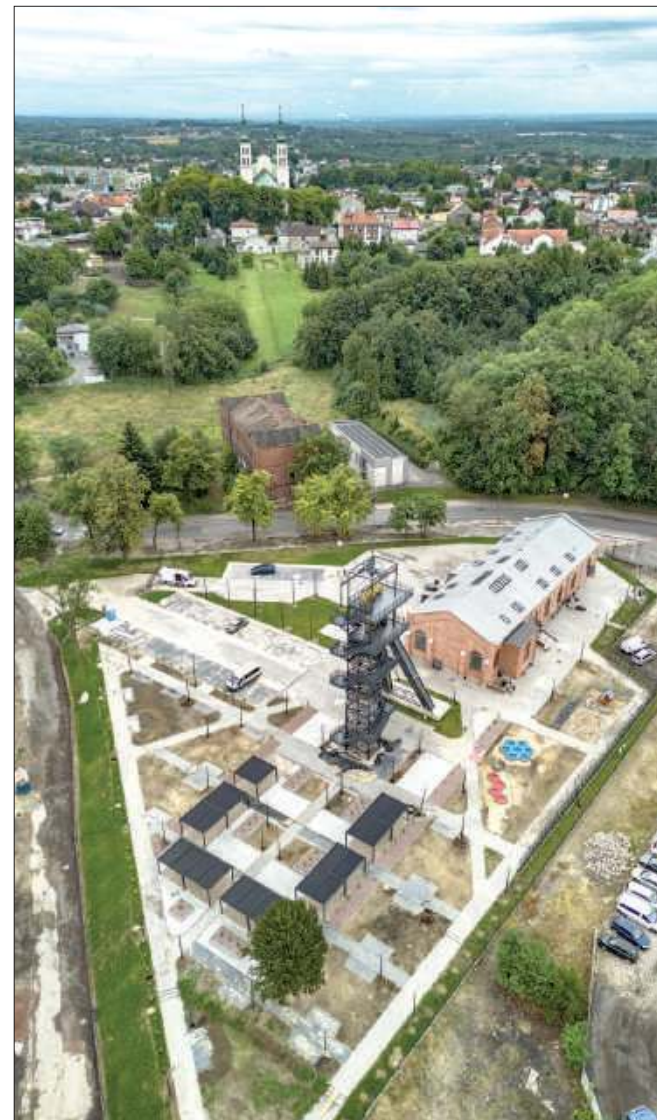
■ Rewitalizacja byłej łaźni to pierwszy etap prac na terenie po kopalni. Kolejny ma być obszar szybu Chrobry
