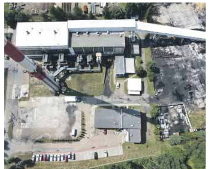
System kogeneracyjny zasilany gazem ziemnym, biomasą leśną i biogazem z lokalnej oczyszczalni ścieków powstanie na placu (z lewej strony zdjęcia), który obecnie wykorzystywany jest do parkowania
