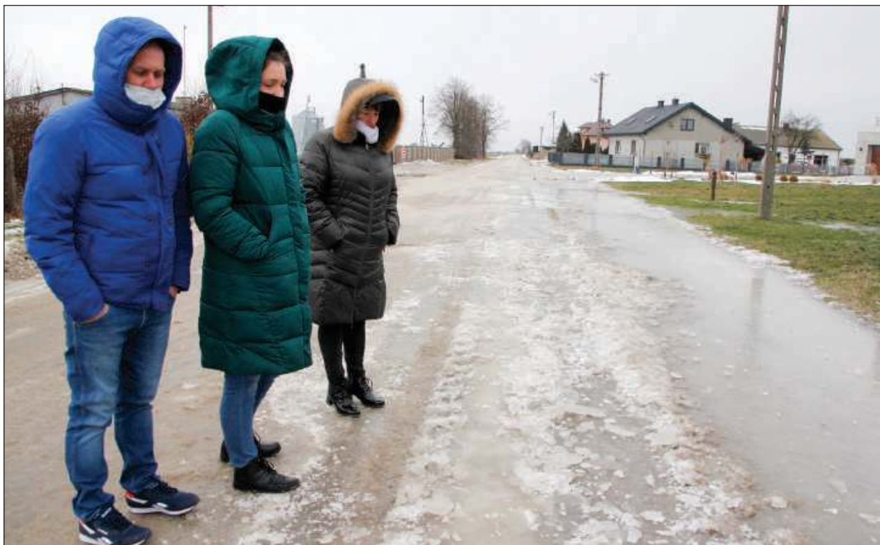
➦ Po opadach i roztopach na drodze tworzy się rozlewisko. Woda zalewa podwórka i piwnice. Gdy ściska mróz robi się lodowisko
