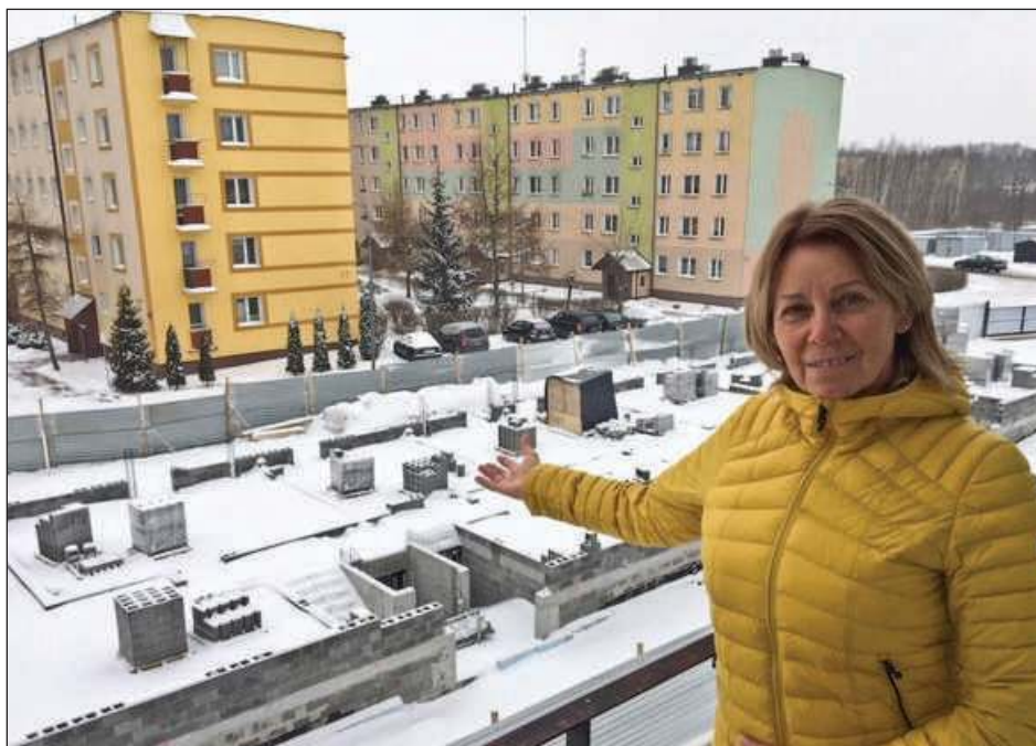
■ - Tu widać budowę. Nowy blok powstanie naprzeciwko naszego i będziemy zaglądać sobie do okien - mówi Jolanta Falkiewicz
