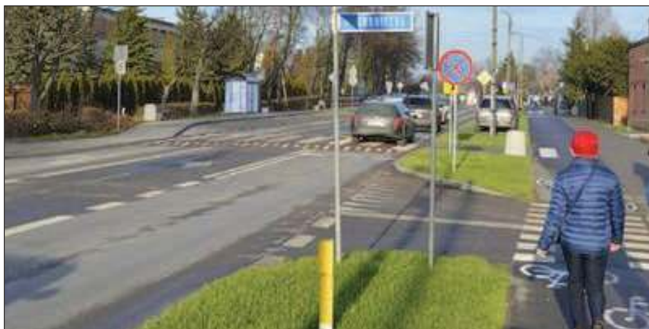
■ Pierwszy etap inwestycji został oddany do użytku jesienią 2019 roku. Kosztował prawie 10 mln zł. Przebudowanych zostało blisko 4 km dróg
