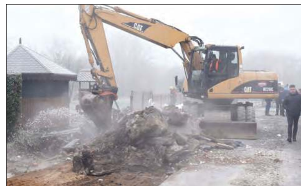
☛ Artur „Pan Koparka” Roczkowski burzy stare fundamenty domu Świtajów
