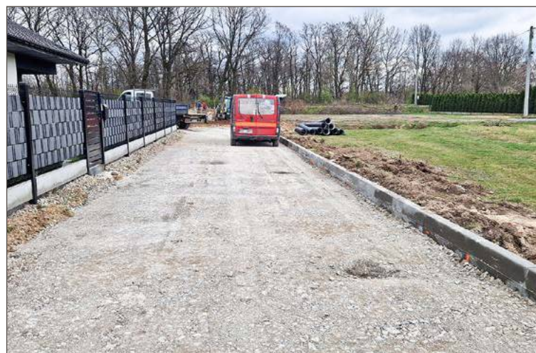
Jedna z dróg budowanych w Straszęcinie.
