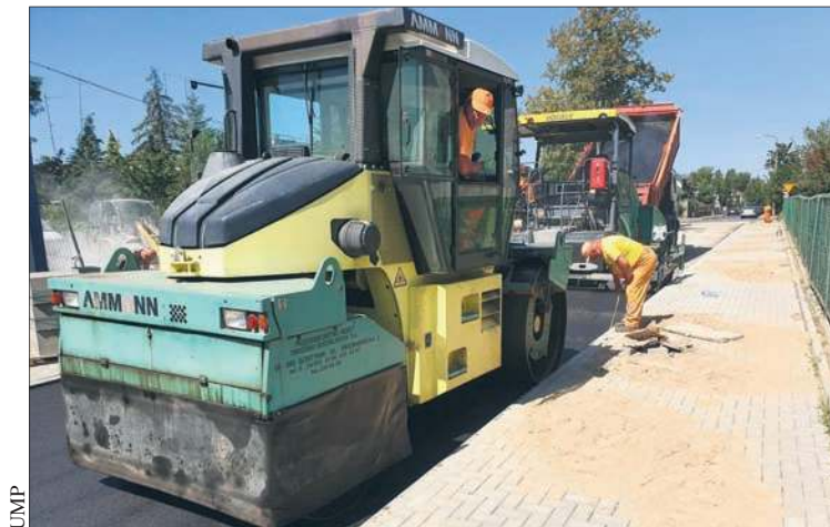
W ubiegłym tygodniu na ulicy Kredytowej była układana pierwsza warstwa asfaltu
