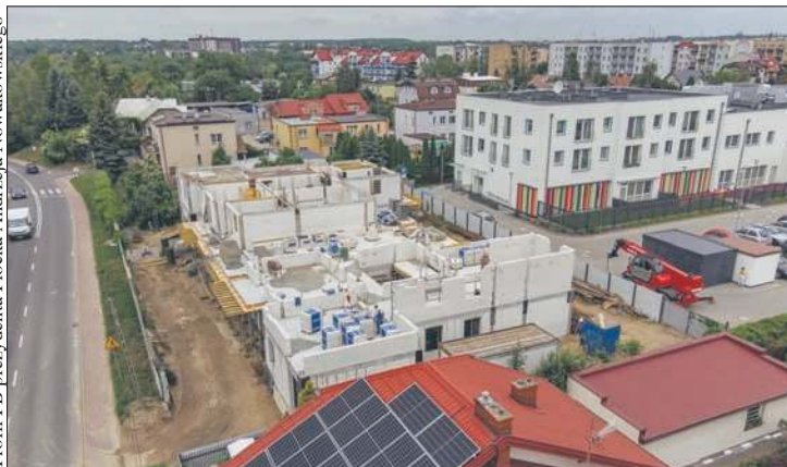
Pomiędzy ulicami Polną i Kazimierza Wielkiego powstaje kolejny budynek mieszkalny
