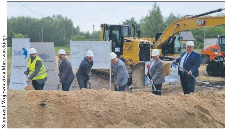
Na budowę obwodnicy mieszkańcy Sierpca czekali ponad 20 lat
