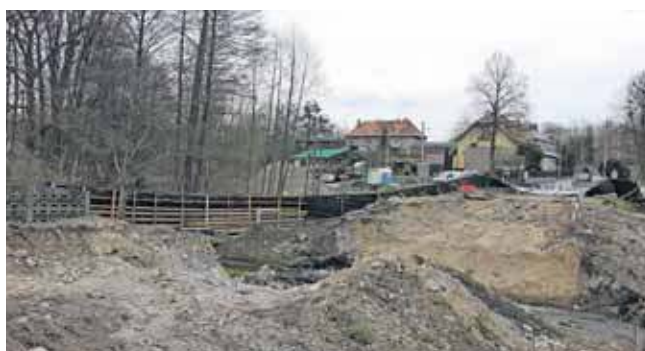
Na razie zamiast mostu jest tylko prowizoryczna kładka. Czy powstanie nowego obiektu do końca maja jest realne?
