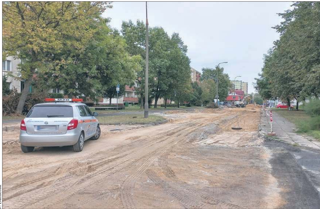
Przebudowa fragmentu ulicy Lasockiego potrwa 5 miesięcy
