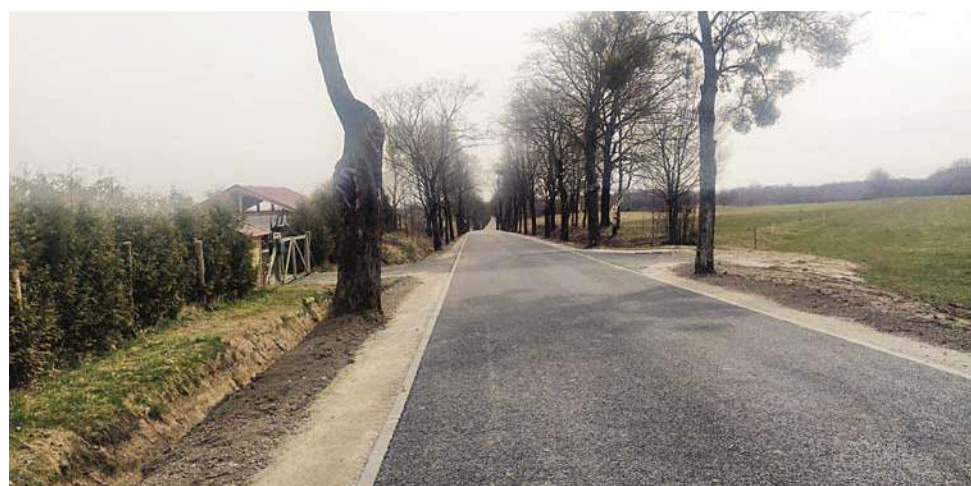
W kwietniu tego roku zakończyła się również przebudowa drogi powiatowej Zastawno – Kwietnik II Etap o długości 1,63 km
