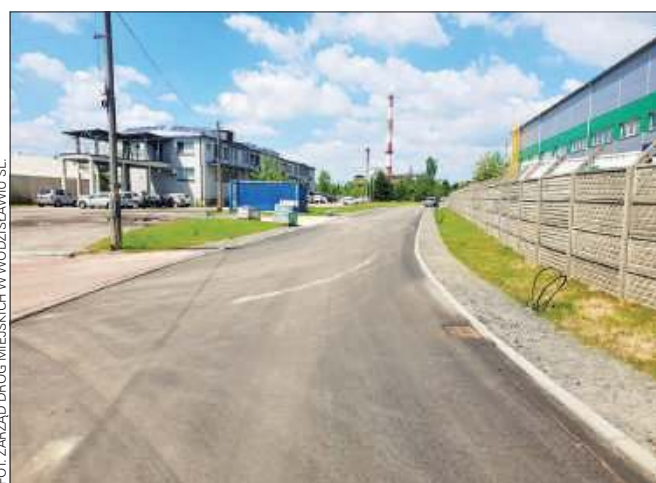
Trzy odcinki drogi, które powstaną na miejskich pokopalnianych terenach, zostaną ze sobą połączone. W efekcie powstanie nowa droga o łącznej długości około 1,7 km.
