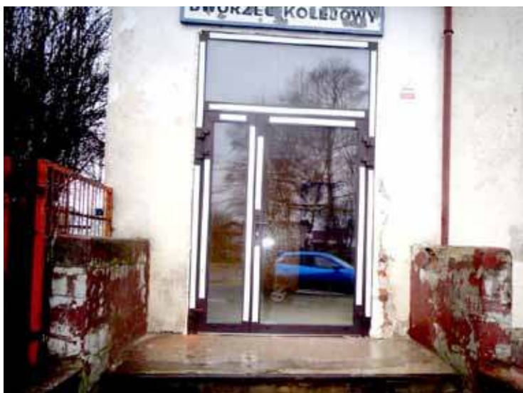
PKP S.A. Oddział Gospodarowania Nieruchomościami Poznań wymienił drzwi i okna w poczekalni dworca kolejowego
