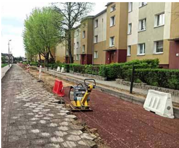
Ze względu na trwające prace ul. Aleja Żołnierza Boczna jest zamknięta dla samochodów
