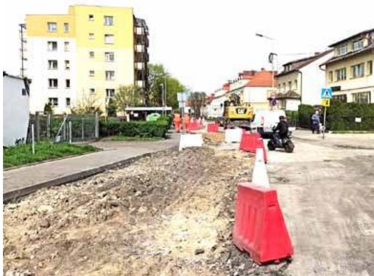
Istniejąca nawierzchnia została sfrezowana
