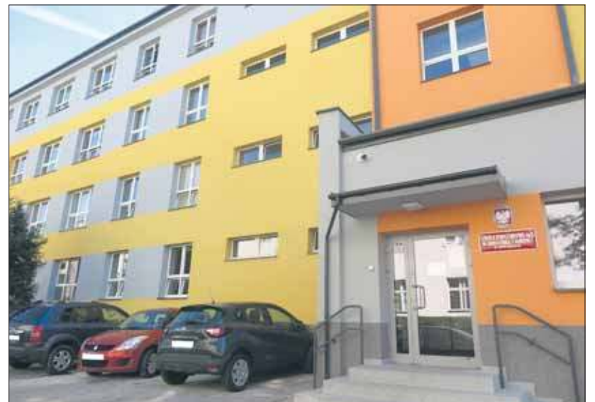
Wyremontowany budynek Szkoły Podstawowej nr 5 na Osiedlu Stałym
