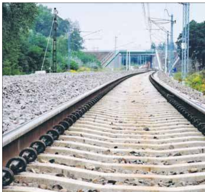
Skutkiem wykolejenia była blokada jednego czynnego toru
