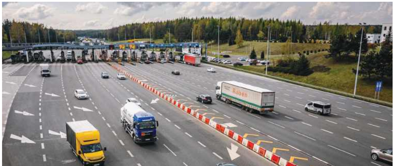
■ Nie tylko koniec opłat, ale też przygotowania do dużej rozbudowy. A4 Katowice – Kraków ma przejść pod zarząd GDDKiA i w przyszłości zostać poszerzona o trzeci pas. FOT. GDDKiA
