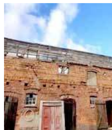
W Gminie Marianowo pozbywano się azbestu zalegającego na dachach nieruchomości
