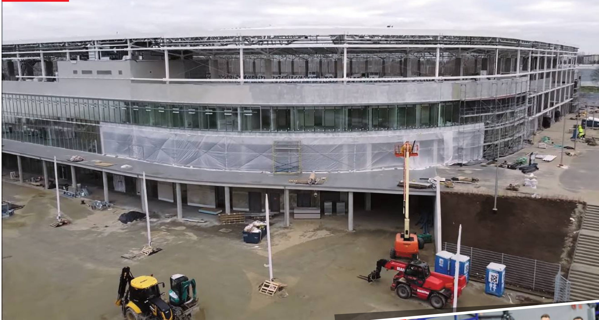
Stadion w Płocku nadal przypomina wielki plac budowy | fot. YouTube/d
