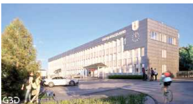
Dwa ważne i historyczne obiekty użyteczności publicznej w Rykach zostaną kompleksowo zmodernizowane. Budynek Urzędu Miejskiego, w którym swoją siedzibę ma również Prokuratura Rejonowa oraz kino Renesans przejdą szeroko zakrojone prace termomodernizacyjne i techniczne
