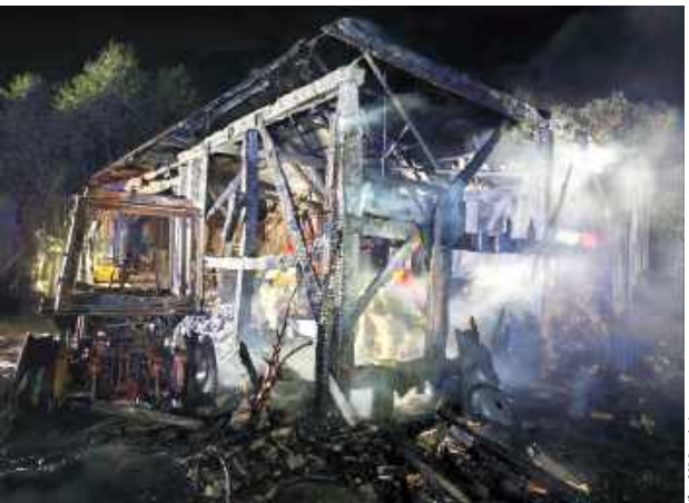
Ogień objął budynek gospodarczy, w którym znajdował się sprzęt rolniczy oraz wyposażenie gospodarstwa. Zagrożony był również znajdujący się w bezpośrednim sąsiedztwie budynek mieszkalny
