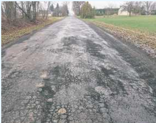
Tak wyglądała droga przed remontem
