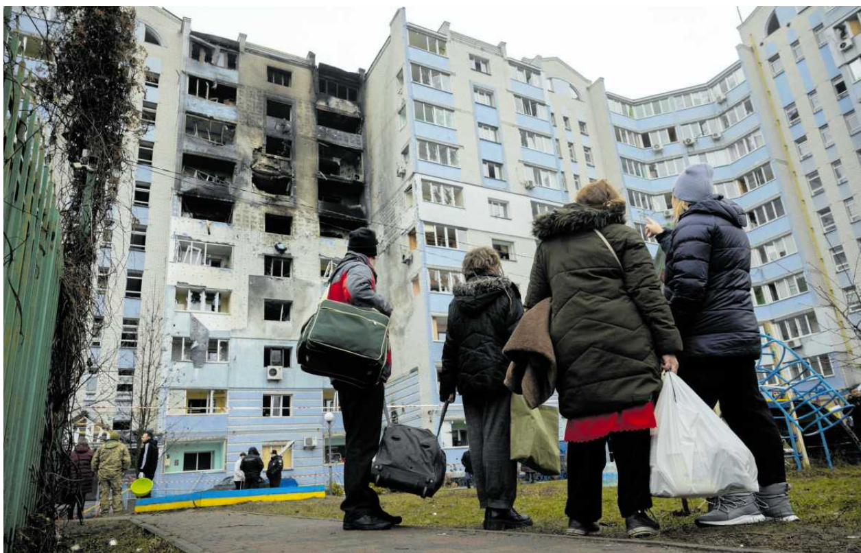
• Zniszczony blok mieszkalny po uderzeniu rosyjskiego drona w mieście Hlewacha w obwodzie kijowskim. 24 stycznia 2025 r. FOT. REUTERS / THOMAS PETER
