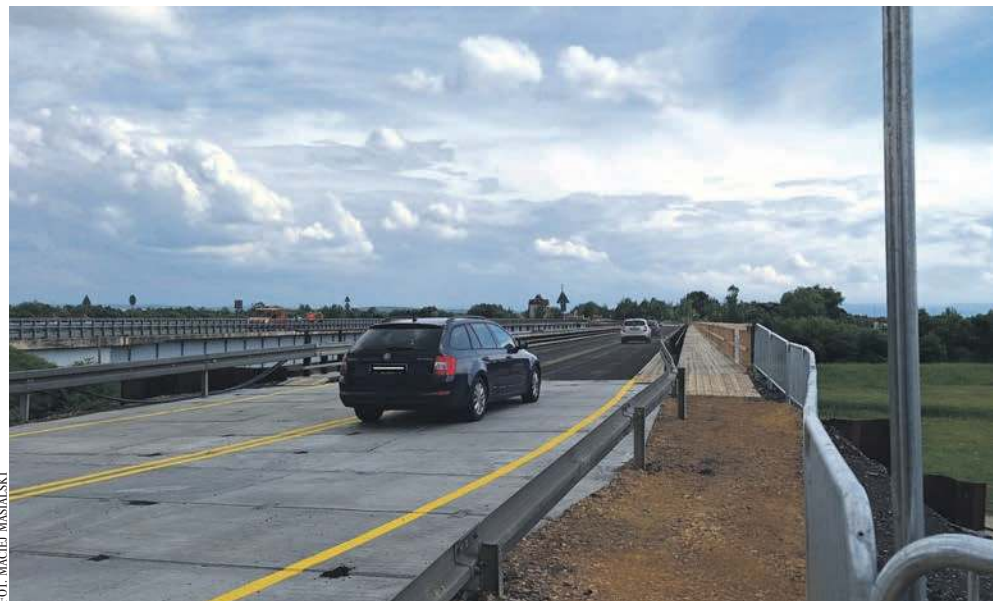
Most tymczasowy na Wiśle w Jankowicach
