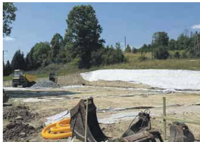
Koszt inwestycji po przetargu to ponad 619 tys. złotych.
