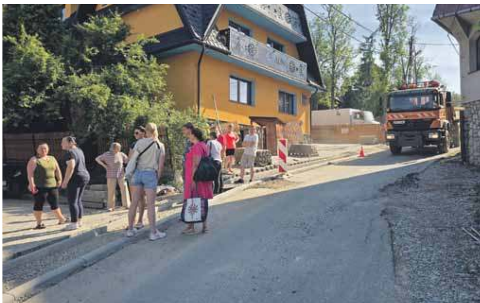
Remont na Walkoszach budzi kontrowersje mieszkańców.
