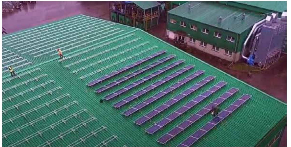
Budowa instalacji fotowoltaicznych na dachu sortowni zakładu w Ślajsinie Foto. Materiały promocyjne RXXI
